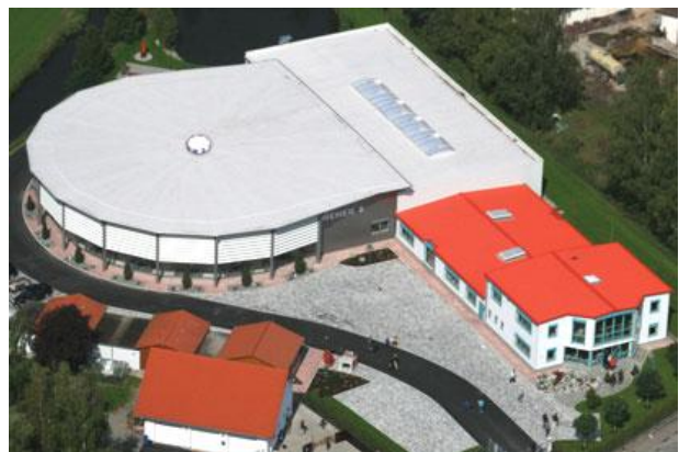
Das charakteristisch-runde Produktionsgebäude
